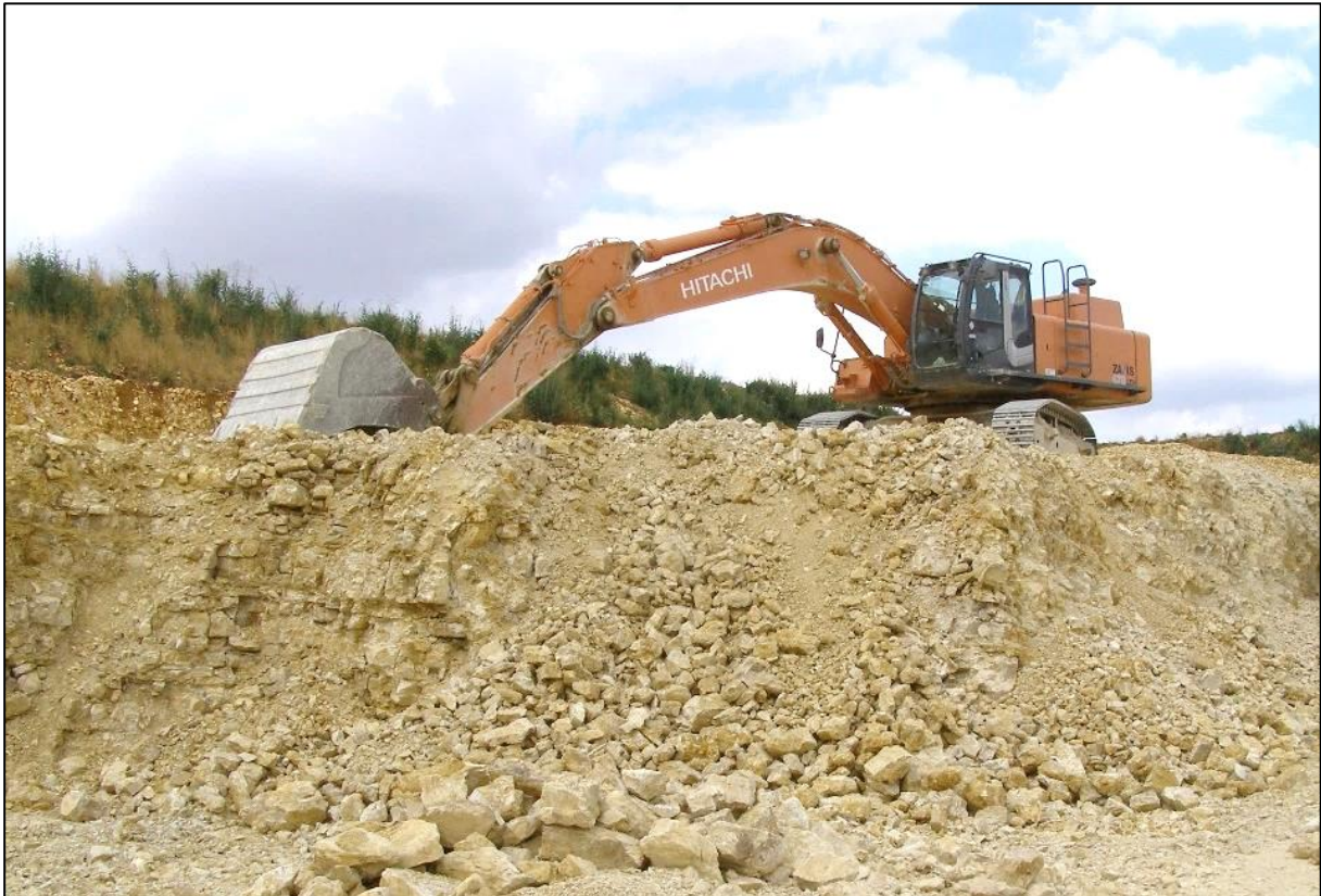
Figure 9 : Extraction du matériau avec une pelle hydraulique munie d'un godet de déroctage
