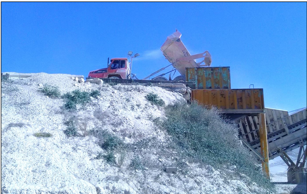
Figure 10 : Alimentation directe de la trémie de réception de l'installation de traitement fixe principale par tombereau (juin 2020)
