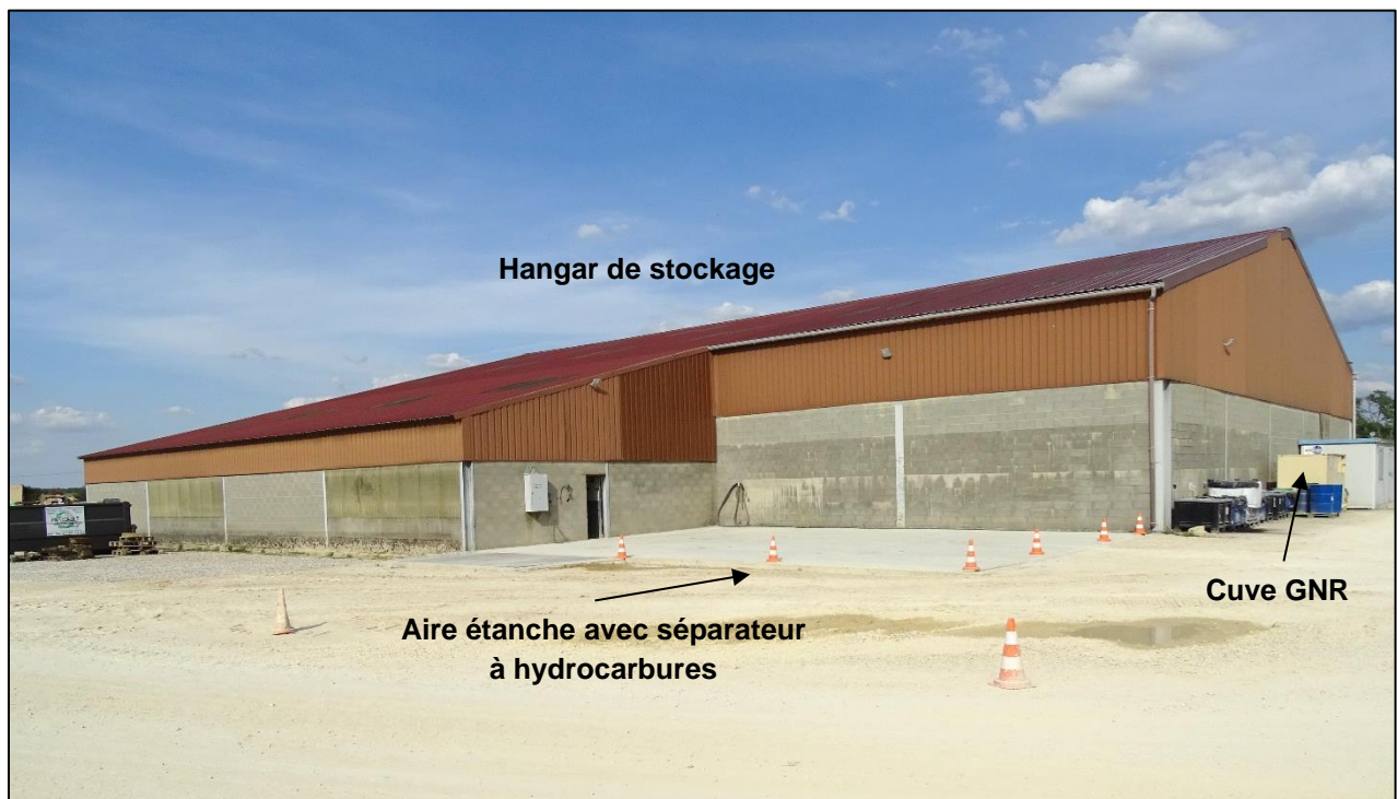
Figure 16 : Hangar de stockage, vue côté sud-ouest (juin 2020)
