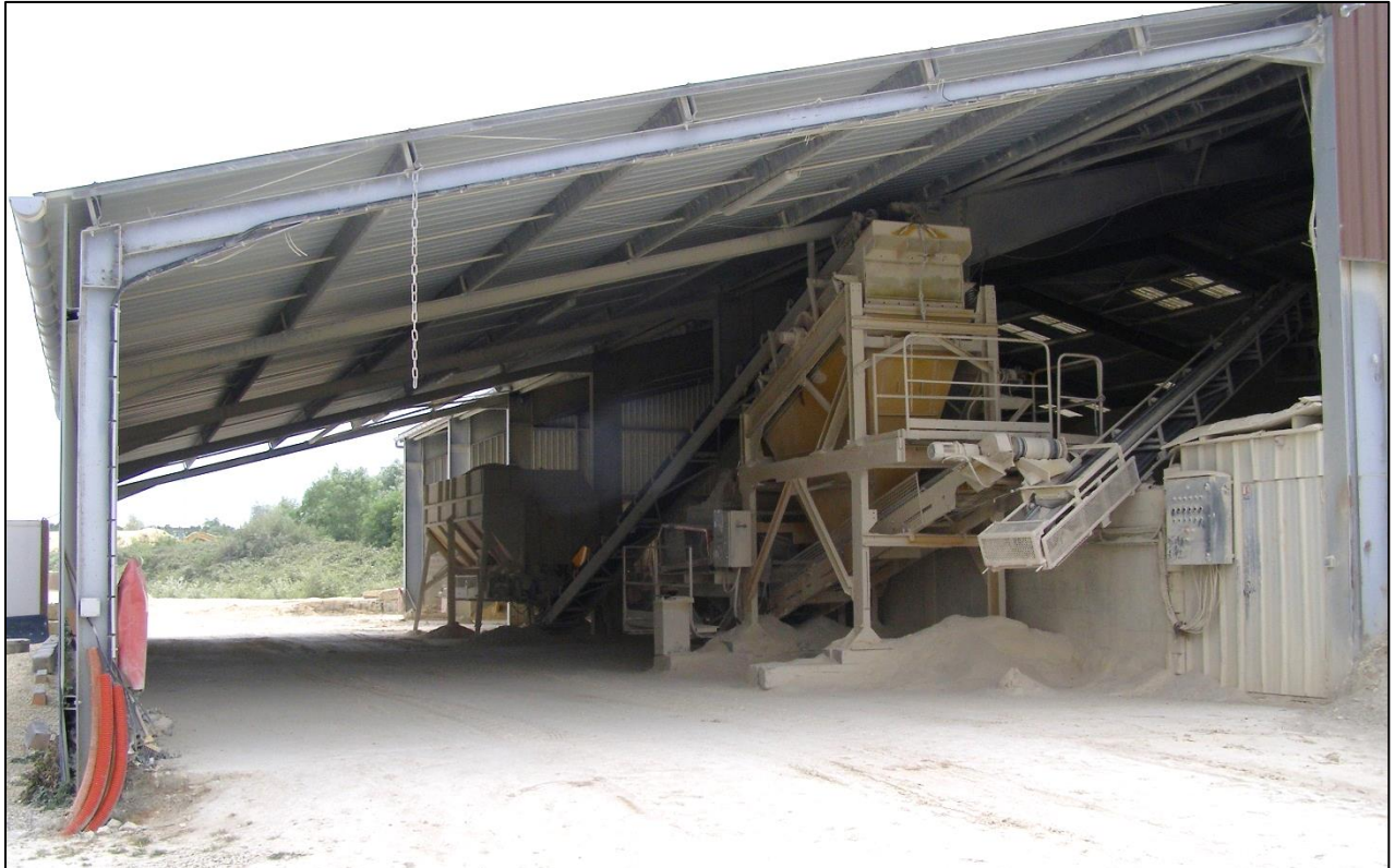
Figure 13 : Station de criblage et broyage des matériaux les plus fins (amendements pour l'agriculture) dans le hangar (10 juillet 2018)
